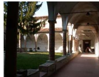
2. Un lato del portico del chiostro interno alla struttura dell'ex-carcere, completato nel XV secolo
