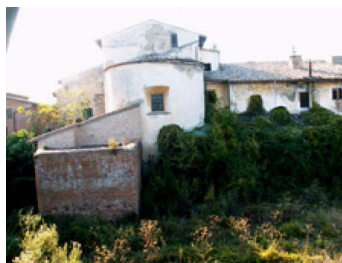
7. La sezione di isolamento con le superfetazioni che occupano la parte esterna dell'abside della chiesa
